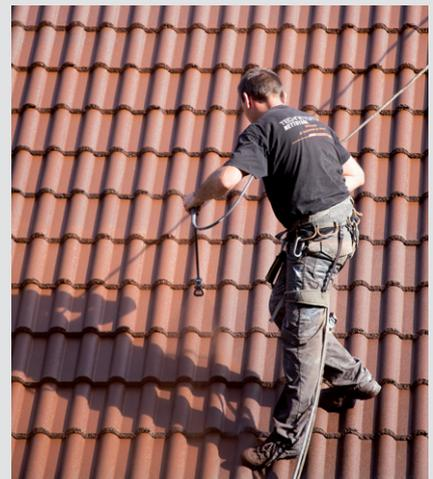
Pour un résultat optimal, ClimateCooler® Uni Roof Topcoat s'applique en 2 couches au rouleau ou au pistolet.
